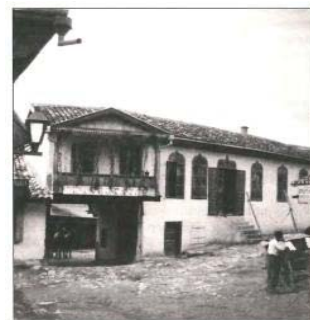
Рис. 18. Будинок на перетині вулиць Леніна і Н.Спаі. Махаллі Орта-джами. Фото С. Некрасова, поч. XX ст. / Fig.18. The house at the intersection of Lenin and N.Spai streets. Mahally Orta Jami. Photo by S. Nekrasov beg. Twentieth century
