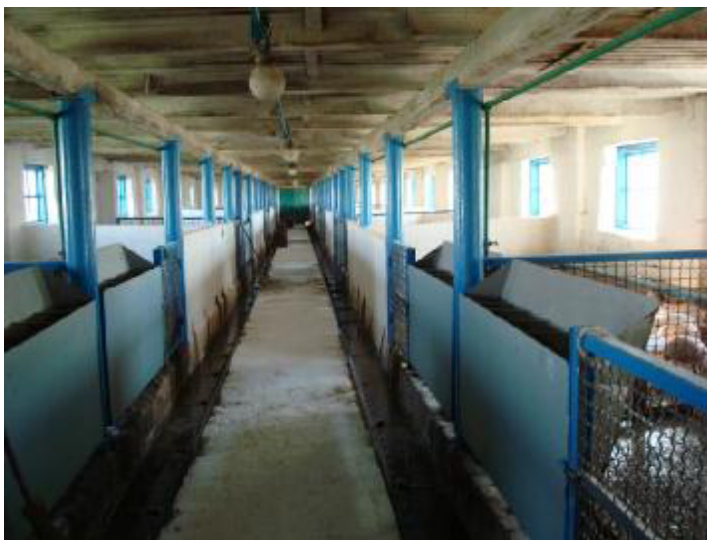
Рис. 2. Приміщення для дорощування поросят (модернізоване).
