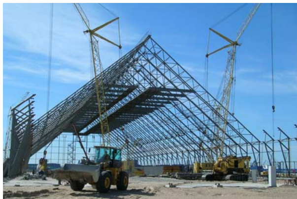
Рис. 1. Зведення поперечних рам каркаса складської будівлі
