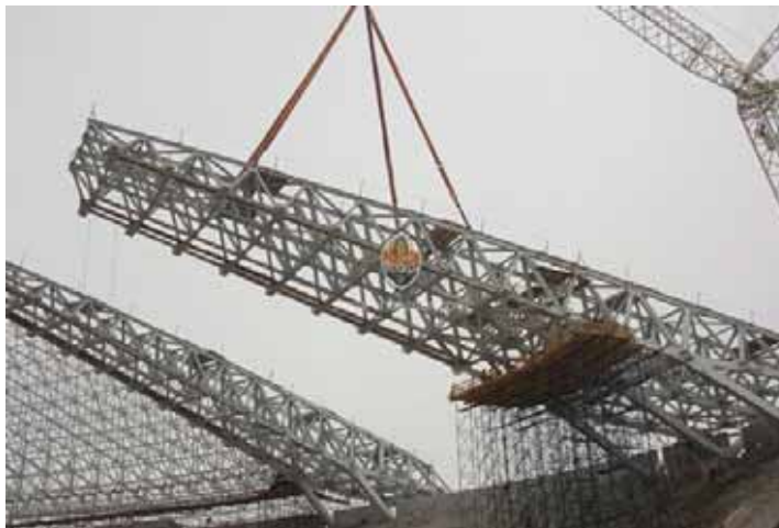
Рис. 3. Пространственная консольная ферма покрытия
