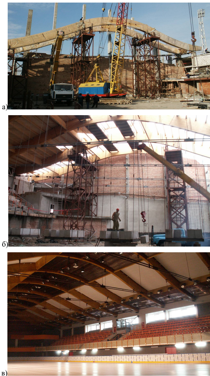
Рис. 4. Монтаж (а), натурные испытания (б) и общий вид (в) конструкций покрытия ледовой арены в г. Пинске
