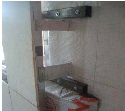
Рис.1. Конструктивні рішення несучої системи навісного вентиляваного фасаду з алюмінієвих сплавів
