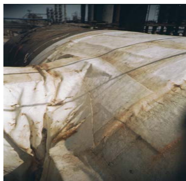
Рис. 7. Тройник коксового газа после ремонтного восстановления
