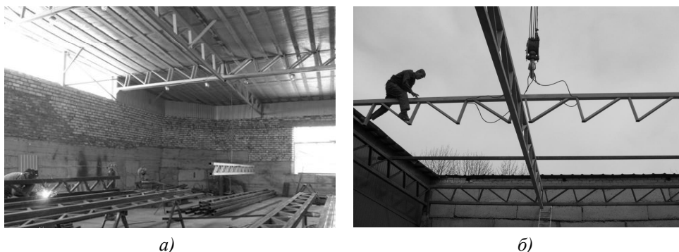
Рис. 5. Снимки изготовления (а) и монтажа (б) пространственной конструкции со съемными нижними поясами
