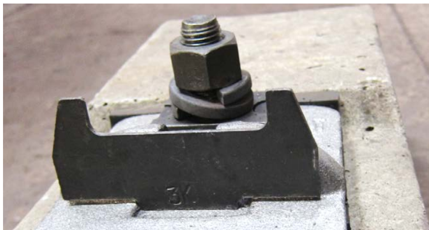
Рис. 5 – Встановлення пластини упорної на підкладці
