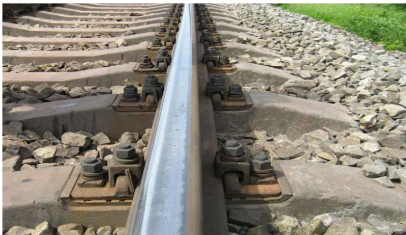
Рис. 3 – Дослідна ділянка колії зі скріпленням типу СКД65-Б
