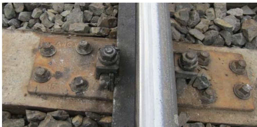
Рис. 4 – Скріплення типу СКД65-Д
