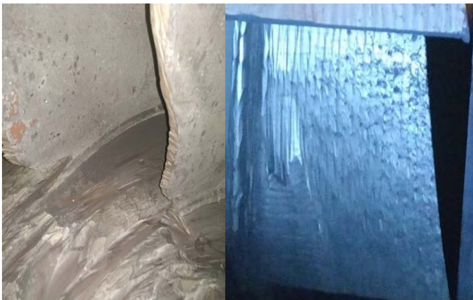
Рисунок 2 – Зношені елементи колеса вентилятора ВМ-180/1100 (5 місяців експлуатації, Запорізька ТЕС)
