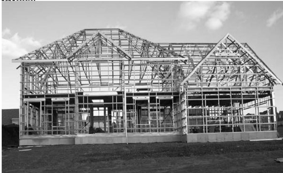
Рисунок 1 – Каркас двоповерхового житлового будинку із ЛСТК
