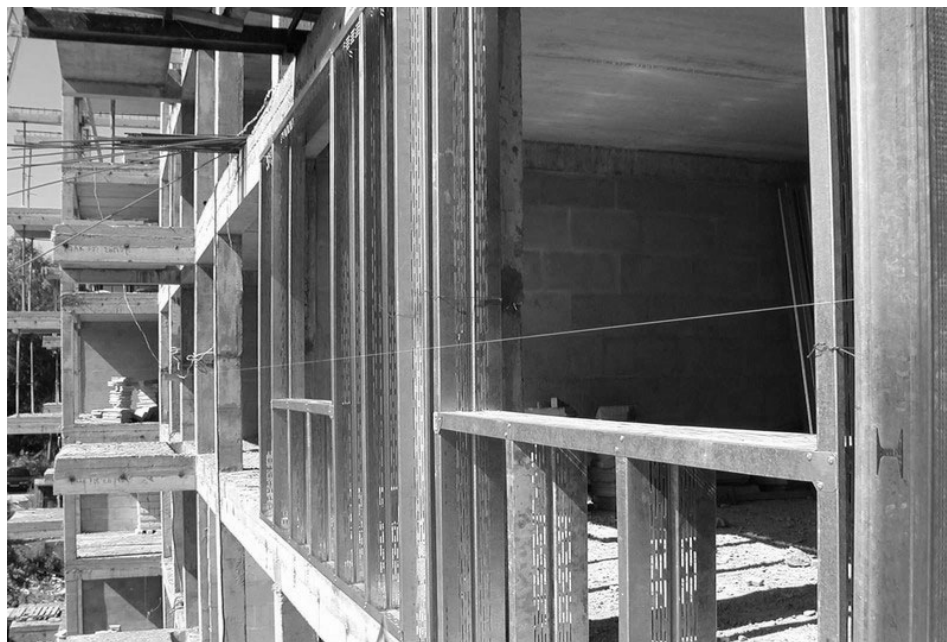
Рисунок 4 – Зовнішня огорожувальна конструкція, виконана із ЛСТК
