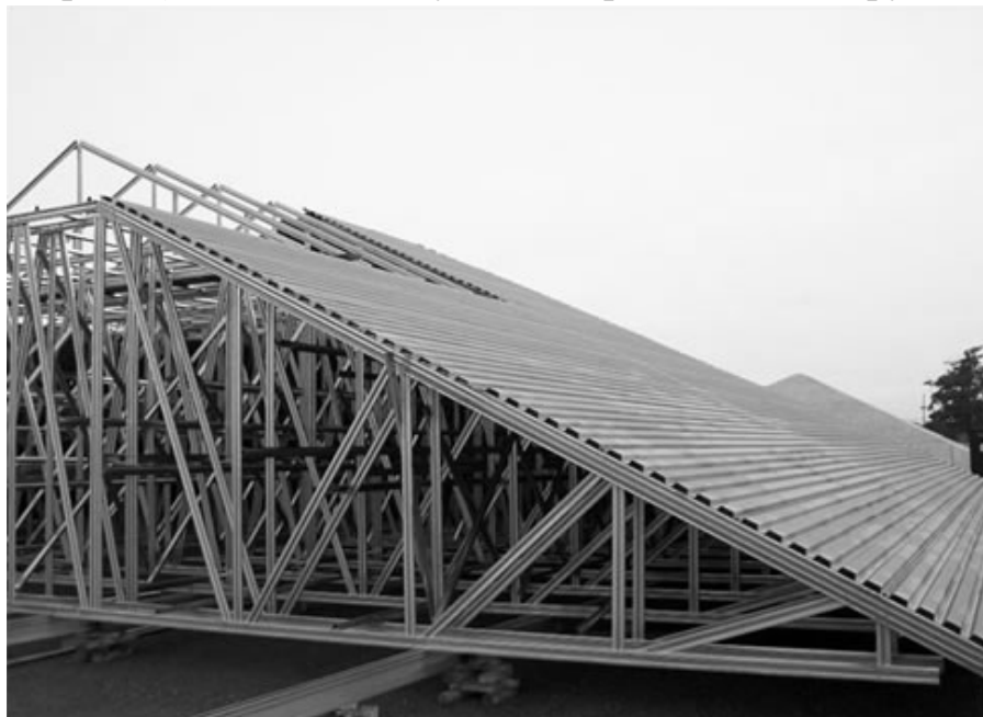
Рисунок 3 – Конструкція покриття з фермами з легких тонкостiнних профiлiв
