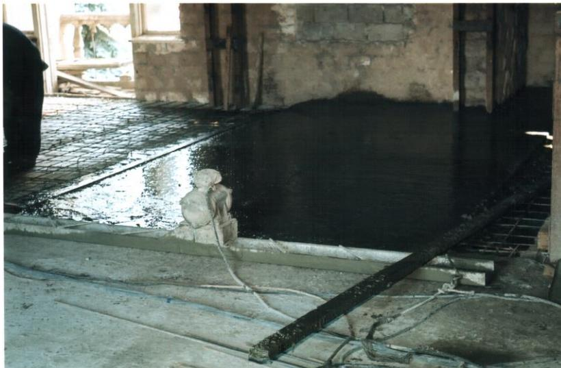
*Рисунок 2 - Бетонирование железобетонной плиты*
