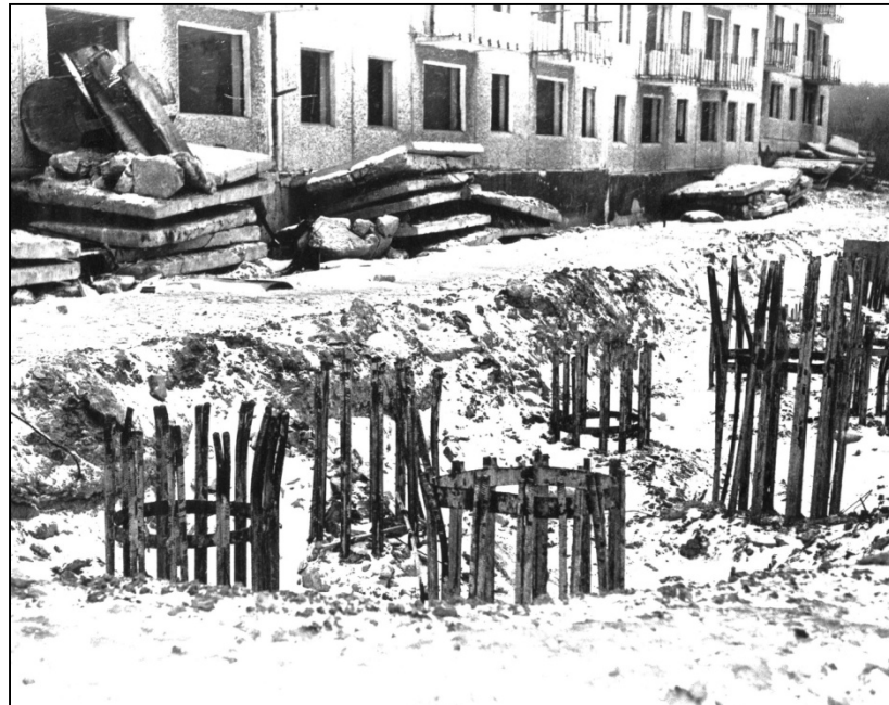
Рисунок 4 – Укріплення схилів Шамишеної балки на території м. Дніпродзержинськ: а – буронабивними палями; б – сучасний стан ділянки (світлина М.Г. Демчишина, 1995 р.)
