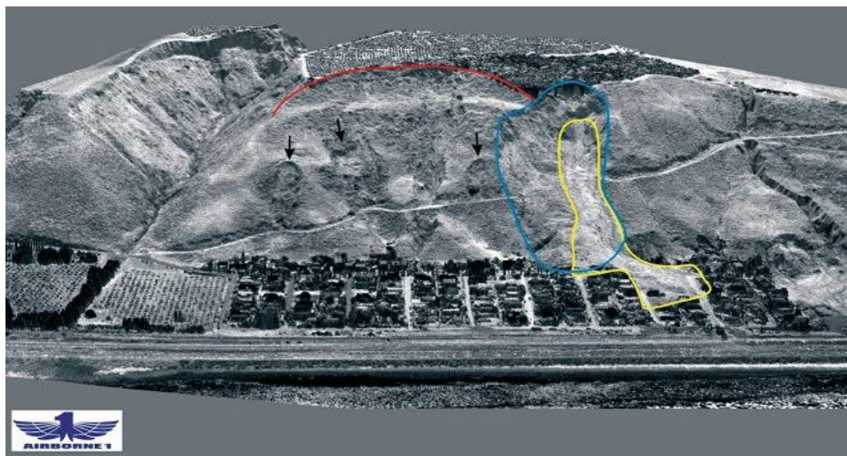
Рисунок 4 – Косе LiDAR-зображення Ла Кончіта (Каліфорнія, США) зсувів, виявлених у 2005 році. Показані контури зсувів 1995 року (синя лінія) і 2005 (жовта лінія), стрілки показують наявність інших зсувів на цій території; червона лінія окреслює головний уступ стародавнього зсуву, який охопив увесь обрив. (Фото повітрянодесантних військ 1, El Segundo (штат Каліфорнія, США) і Randy Jibson, геологічна служба США [14])
