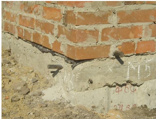
Рисунок 3 – Стінові осадкові марки, влаштовані на об'єкті досліджень
