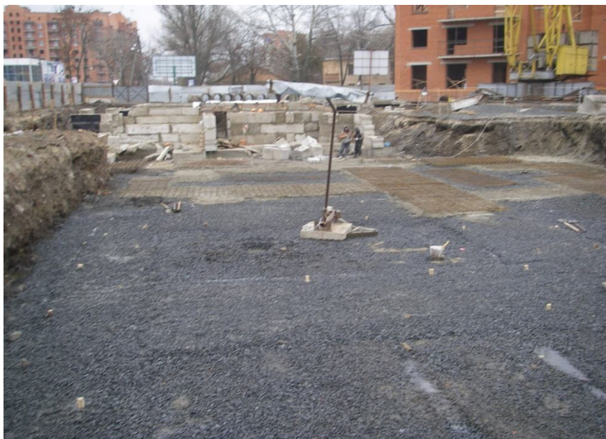
Рисунок 2 – Зведення стрічкових монолітних фундаментів на щебеневій подушці, відсипаній поверх основи, армованій ґрунтоцементними елементами
