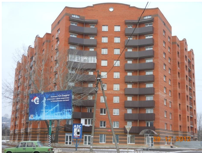
Рисунок 4 – Об'єкт геодезичних спостережень – житловий будинок по вул. Панянка, 65-б, у м. Полтава (на кінець 2012 р.)
