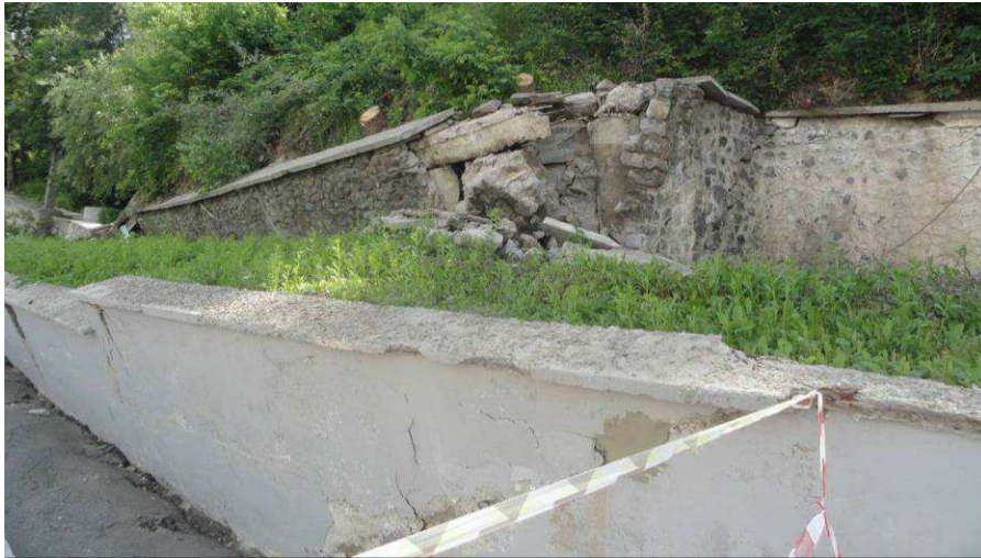
Рис. 2. Загальний вигляд підпірної стіни внизу схилу після зсуву
