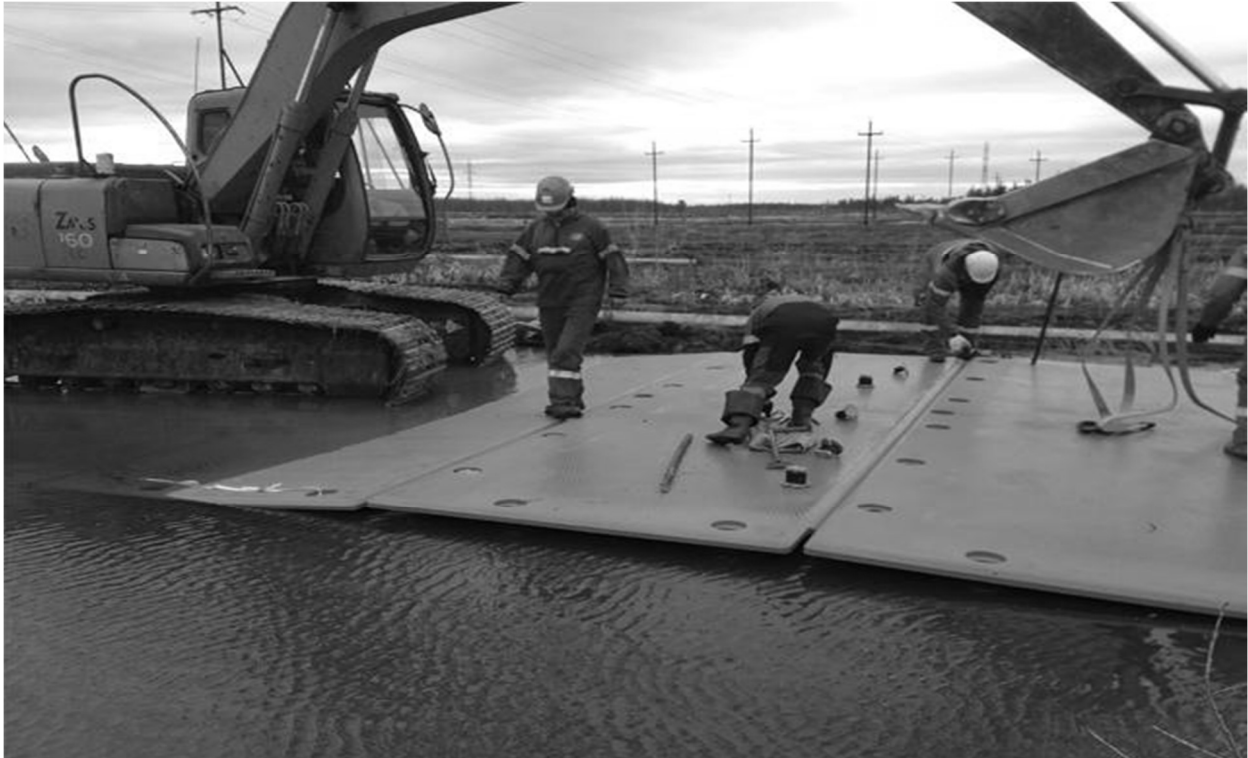
Рисунок 3 – Мобільне дорожнє покриття "МОБІСТЕК" [5]
