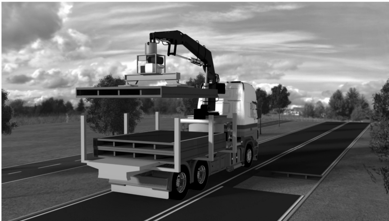
Рисунок 1 – Укладання Plastic Road [3]
