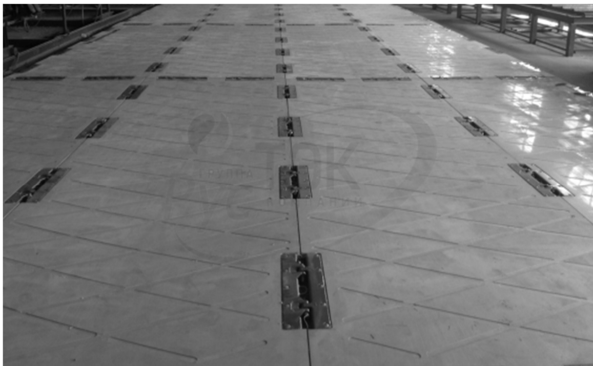
Рисунок 2 – Застосування модульних дорожніх покриттів МДП Р-ПЕК [4]
