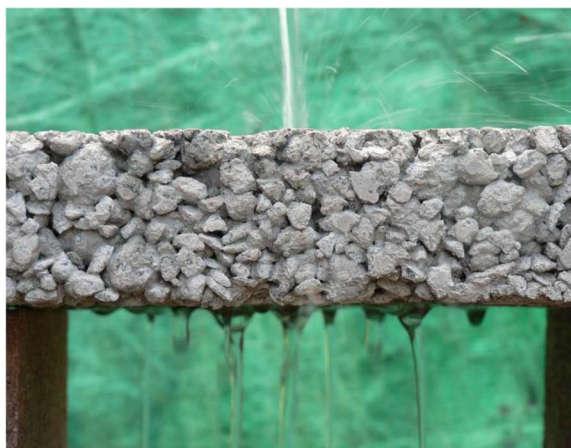
Рисунок 1 – Загальний вигляд дренажного бетону
