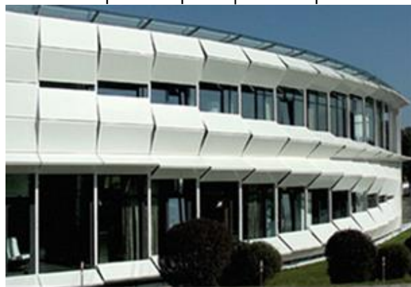
Рис. 4. Сонцезахисна регульована фасадна система на офісній будівлі Kiefer Technic Architecture Showroom, розроблена студією Ernst Giselsbrecht + Partner, Австрія
