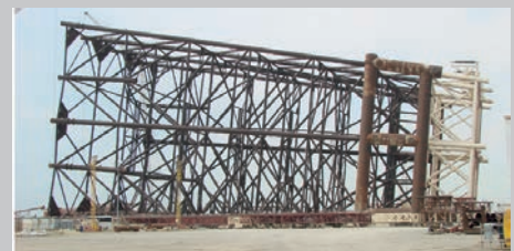
Базова платформа МСП-7 з варними понтонами
