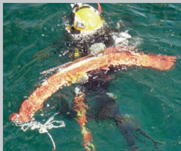
Перенесення заряду водолазом до місця встановлення
