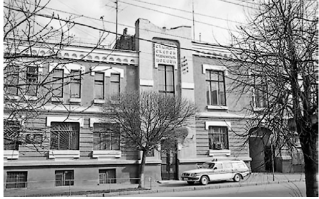
Рис. 12. Будівля станції ШМД на вул. Червоножовтневій, 41, у м. Харків, 2008 р.
