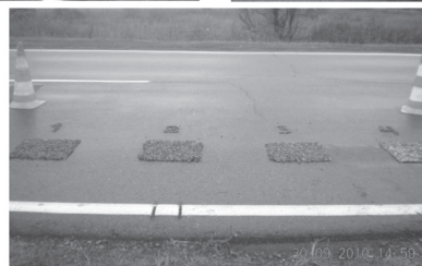
Рис. 5. Влаштування квадратів з поверхневої обробки
