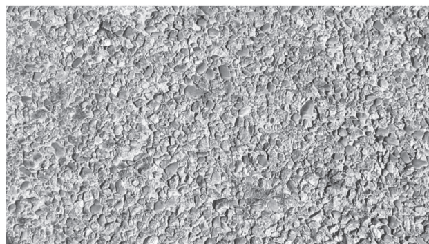
Рис. 4. Фотографія проїзної частини, з якої була відібрана проба гравію, через один рік після введення в експлуатацію
