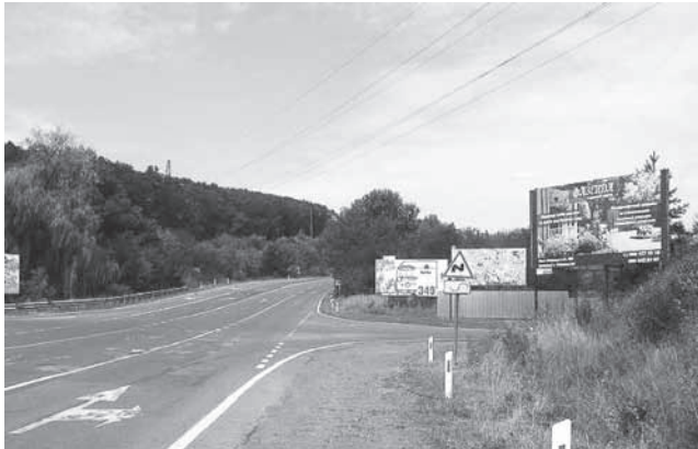
Рис. 1. М-08 Обхід м. Ужгорода – КПП “Ужгород” км 8+440 (порушення: не погоджений, порушення нормативів, неестетичний вигляд)
