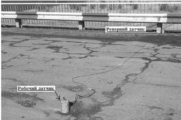
Рис. 3. Сейсмоприймачі встановлені на проїзній частині шляхопроводу
