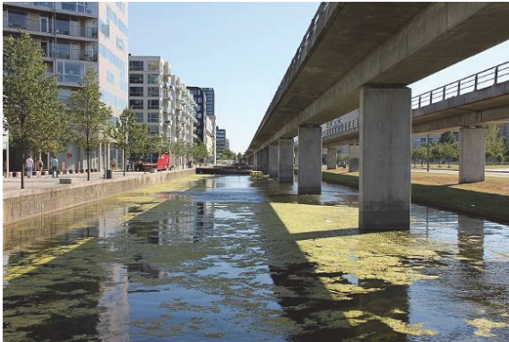
Рис. 4. Копенгаген, Оерестад. Водозбірний канал під естакадою
