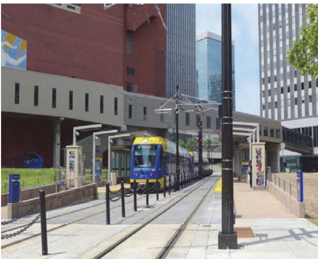
Рис. 1. Вид на пешеходные тоннели с проезжей части, Сент-Пол, Миннесота.
