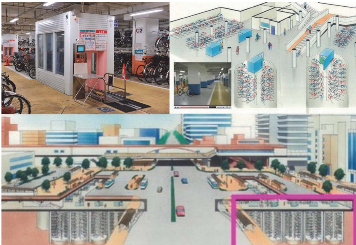
Рис. 2. Kasai station – підземний автоматизований паркінг для велосипедів у м. Токіо, Японія. Місткість 9400 велосипедів. https://velomesto.com/magazine/tech/veloparkovka-eco-cycle-yaponskaya-tehnologiya-umnogo-hraneniya-velosipedov
