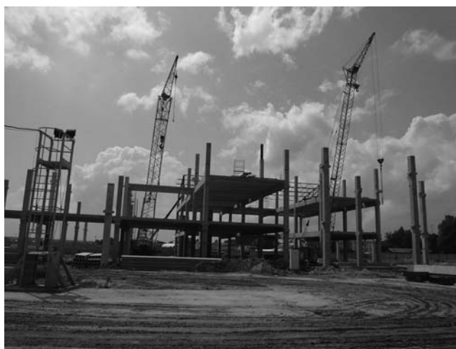
Рисунок 2 - Строительство аэропорта «Жуляны» с использованием сборных железобетонных конструкций производства ПСГ «Ковальская»
