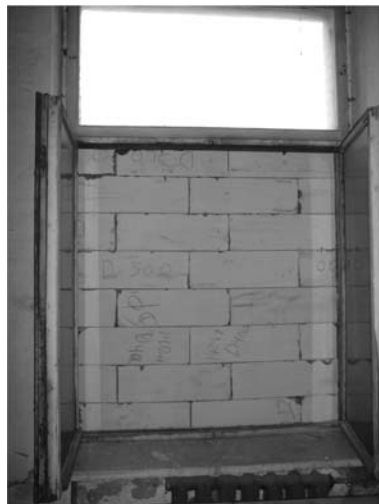
Рисунок 3 – Зовнішній вигляд фрагментів огорожувальних конструкцій з автоклавного бетону зі сторони лабораторного приміщення
