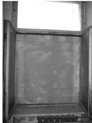
Рисунок 3 – Зовнішній вигляд фрагментів огорожувальних конструкцій з автоклавного бетону зі сторони лабораторного приміщення
