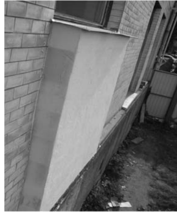
Рисунок 2 – Дослідні фрагменти огорожувальних конструкцій з автоклавного ніздрюватого бетону відразу після укладання блоків (а) та після влаштування штукатурного шару (б)
