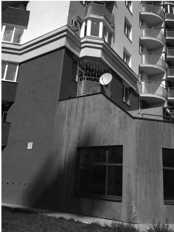
Рисунок 2 - Білі плями та розводи на фасадах житлових будівель
