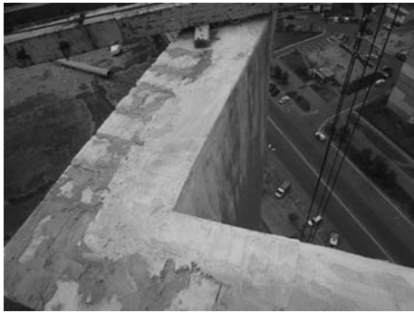
Рисунок 3 - Утворення сольових потьоків на фасадах житлових будівель.
