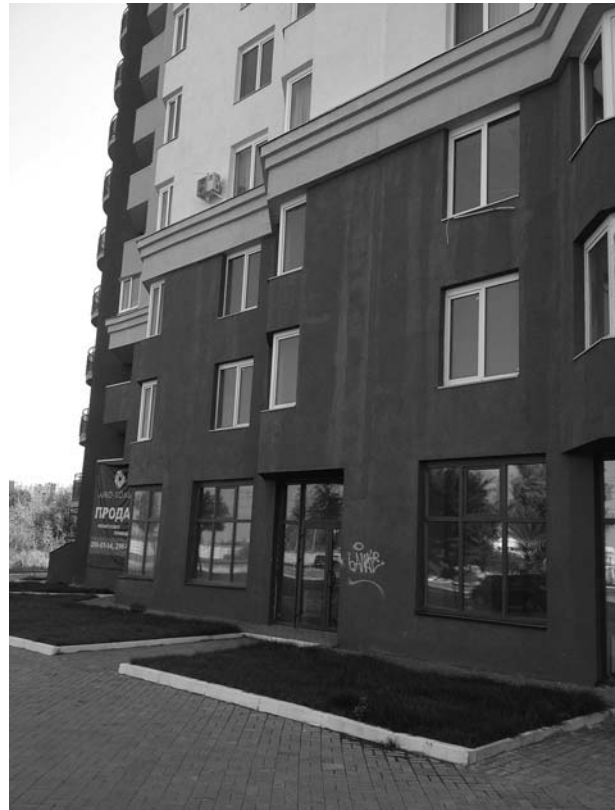
Рисунок 2 - Білі плями та розводи на фасадах житлових будівель
