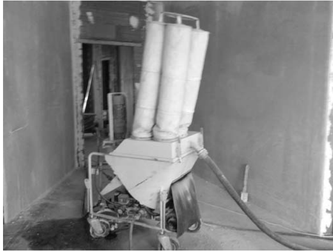
Фото 4. Штукатурна станція для приготування та нанесення розчинової суміші
