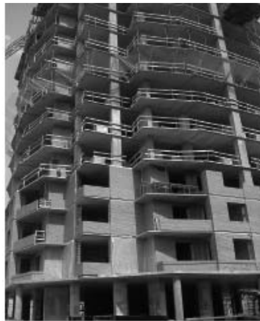
Рисунок 8, 9. Жилые дома монолитно-каркасного типа с наружными стенами из газобетонных блоков и облицовкой лицевым кирпичем на массиве «Троещина», 10 мкрн., г.Киев
