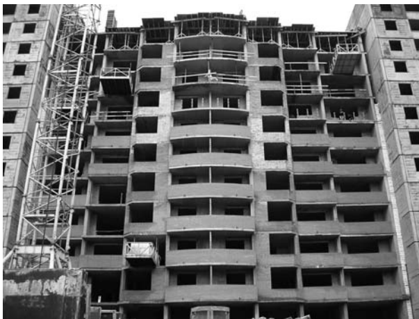
Рисунок 4. Ж.д. №5, масив «Троещина», 10 мкрн., г.Київ; монолітно-каркасна вставка - вид фасада з двору
