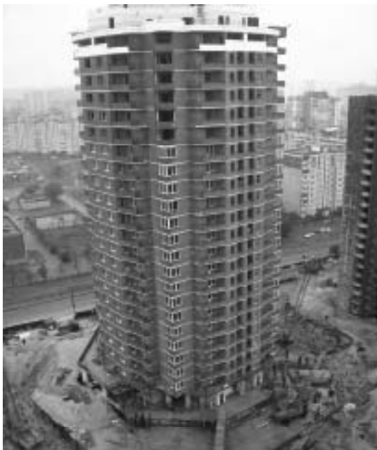
Рисунок 8, 9. Жилые дома монолитно-каркасного типа с наружными стенами из газобетонных блоков и облицовкой лицевым кирпичем на массиве «Троещина», 10 мкрн., г.Киев
