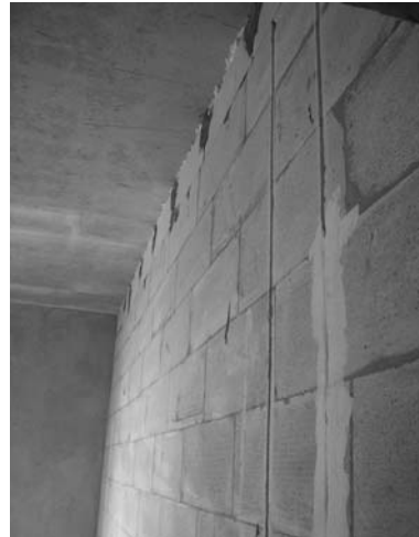
Рисунок 3. Ж.д. по ул.Срібнокильська, 3; внутрішні стіни зі штрабами для електричної проводки
