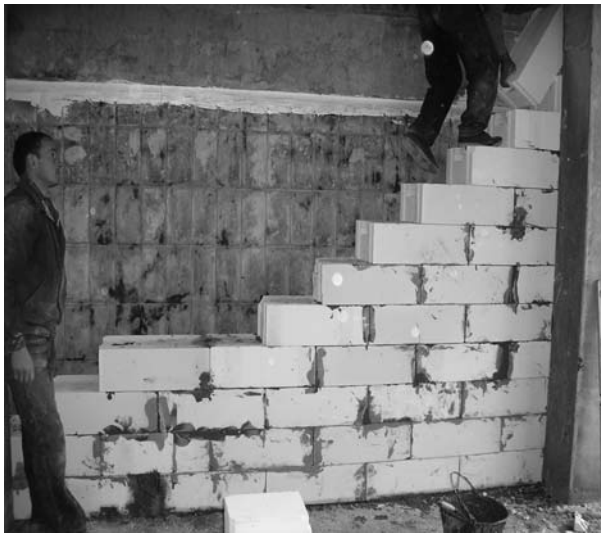
Рисунок 6. Ж.д. №10, массив «Троещина», 10мкрн., г.Киев; выполнение кладки торцевых стен из газобетонных блоков изнутри дома
