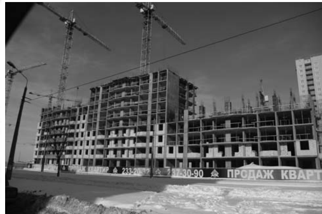
Рисунок 13. Строительство монолитно-каркасного жилого дома №10, массив «Троещина», 20 мкрн., г.Киев
