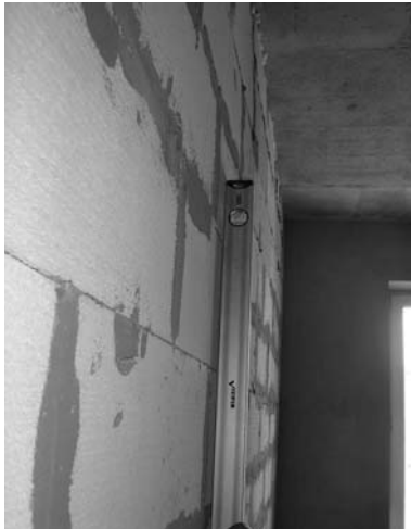
Рисунок 2. Ж.д. по ул.Срібнокильська, 3; внутрішні стіни з газобетонних блоків
