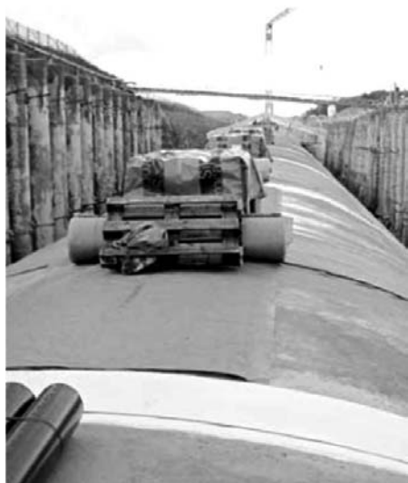
Рисунок 12. Тоннель, Швейцария. Разделение гидроизоляции тоннеля на секции
