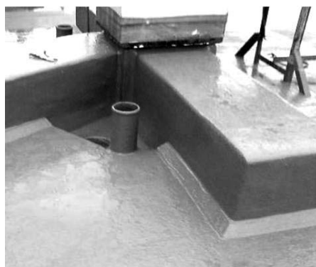
Рисунок 5. Узел с жидкой полиуретановой мембраной
