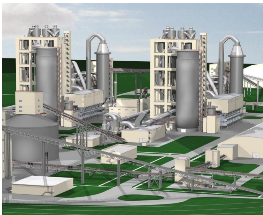
Рис. 9. Цементный завод ООО «Альтцем» в г. Керчь АР Крым (Этажерка теплообменников)
