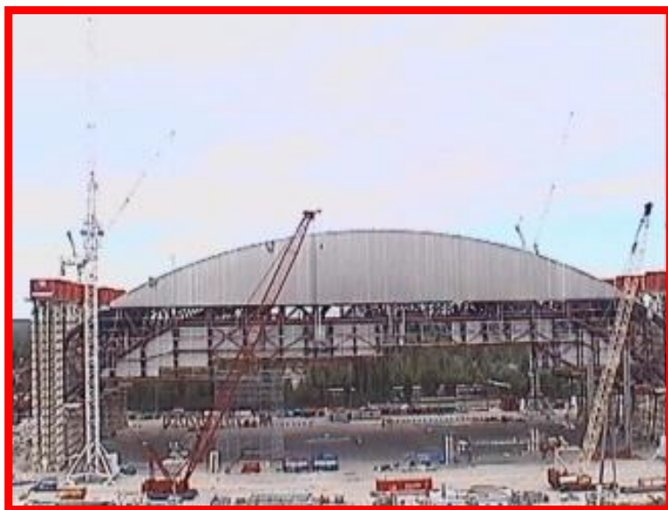
Рис. 2. Новый безопасный конфайнмент над «Объектом Укрытие» ЧАЭС
