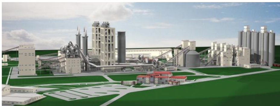
Рис. 8. Цементный завод ООО «Альтцем» в г. Керчи АР Крым (Усреднительный склад основного сырья)
