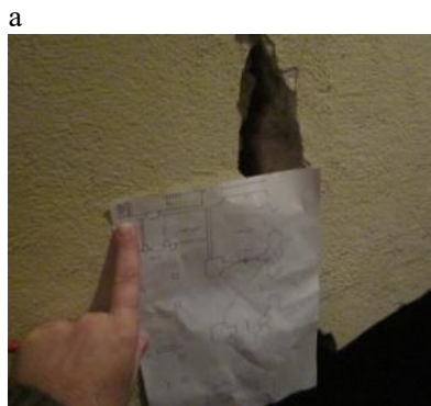
а – дефекты кирпичного свода; б - проектное решение усиления оснований Рис. 1. Здание государственного архива
