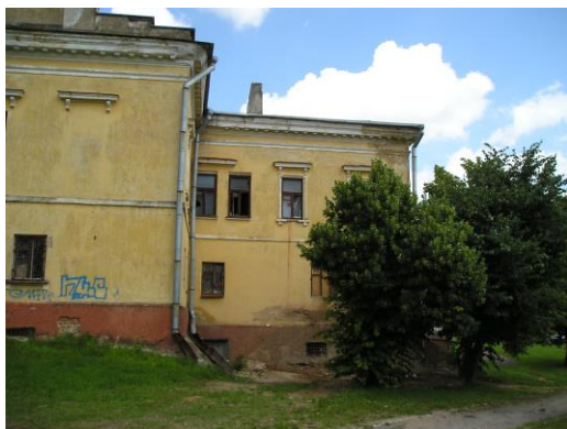
Рис. 2. Боковой фасад здания
