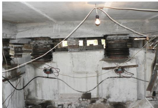
Рис. 1. Загальний вигляд будинку по вул. Гудименко, 17 в м. Запоріжжя; фрагмент зазору після підйому будинку
