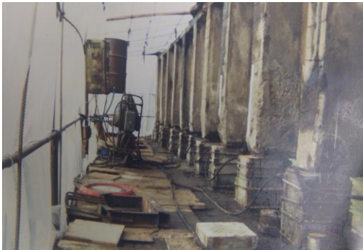
Рис. 4. Загальний вигляд шляхопроводу, та фрагмент піднятих балок шляхопроводу
