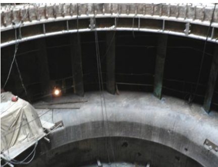
Рис. 1. Загальний вигляд гідроагрегату і штраби після виїмки бетону в період реконструкції
