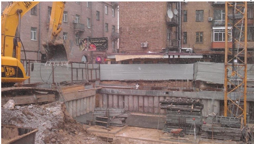
Рис. 2 – Вигляд будівельного майданчика на стадії виконання робіт зі зведення підземної частини
