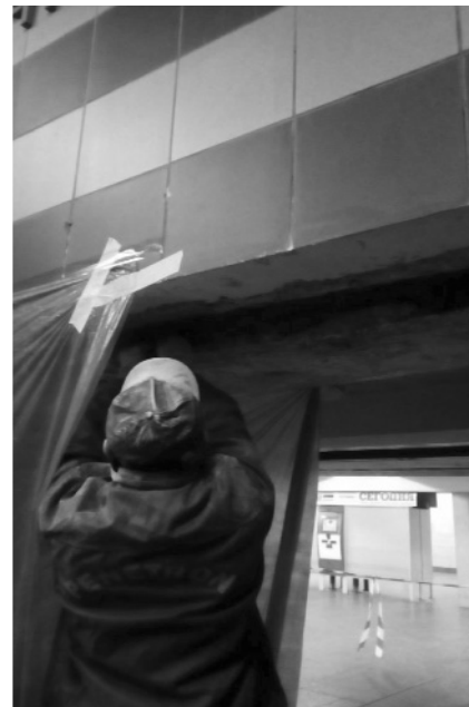
Оконтурування дефекту (вирубка бетону) на глибину не менш 5 мм
