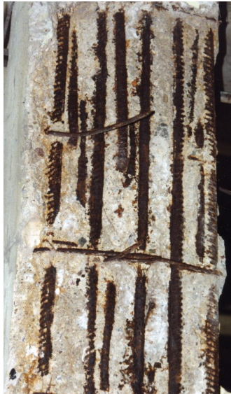
Рисунок 4 - Железобетонная колонна после отделения наружного пласта бетона. Хомуты уничтожены коррозией.
