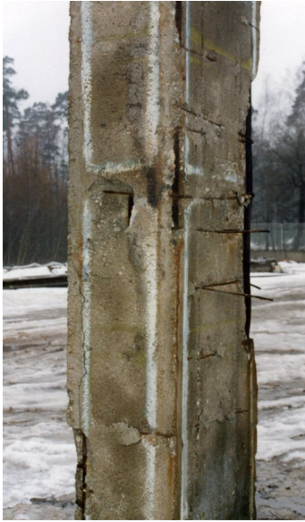
Рисунок 1 - Железобетонные колонны, подвергнутые коррозии
