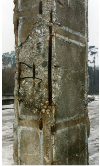
Рисунок 1 - Железобетонные колонны, подвергнутые коррозии
