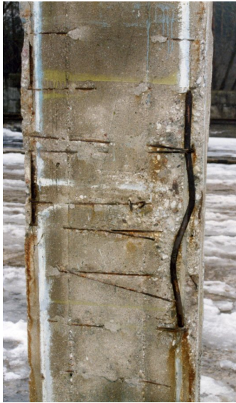
Рисунок 2 - Железобетонные колонны с механическими повреждениями и перемещенными хомутами
