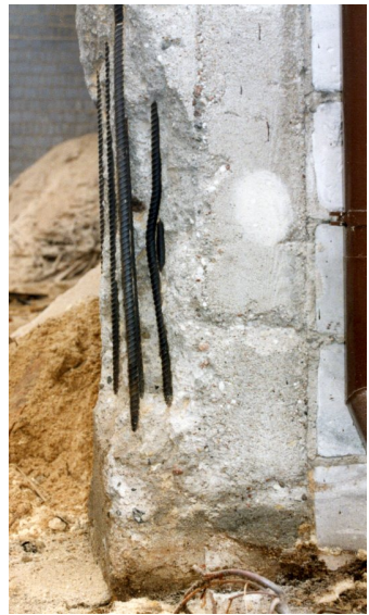
Рисунок 2 - Железобетонные колонны с механическими повреждениями и перемещенными хомутами
