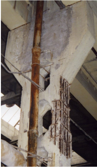
Рисунок 3 - Двухветвевая колонна с сильно развитой коррозией
