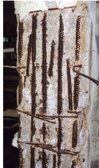
Рисунок 4 - Железобетонная колонна после отделения наружного пласта бетона. Хомуты уничтожены коррозией.
