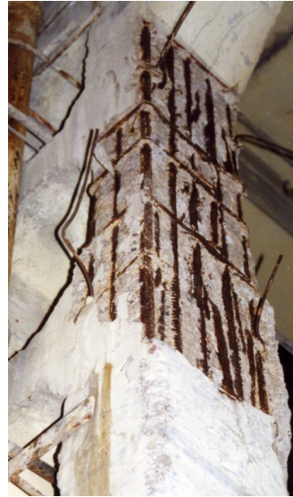
Рисунок 3 - Двухветвевая колонна с сильно развитой коррозией
