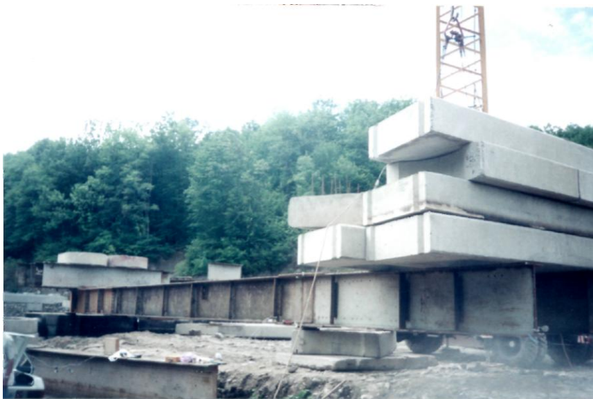
Рис. 2. Випробування дослідної конструкції, змонтованої з металевих балок тривалого зберігання
