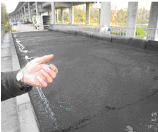
Рис. 6. Поверхня з гідроізоляційним матеріалом “Флексігум-ХП”
