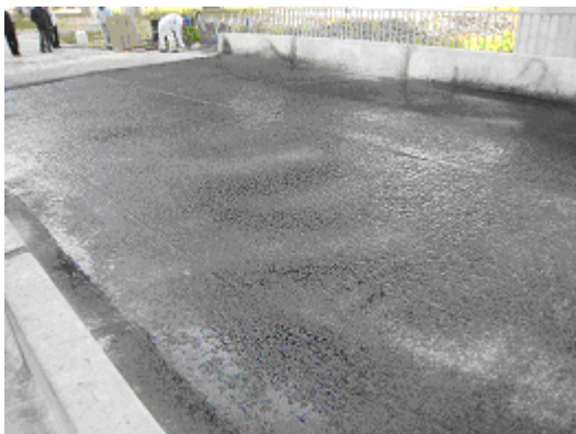
Рис. 4. Ґрунтовка на проїзній частині мосту
