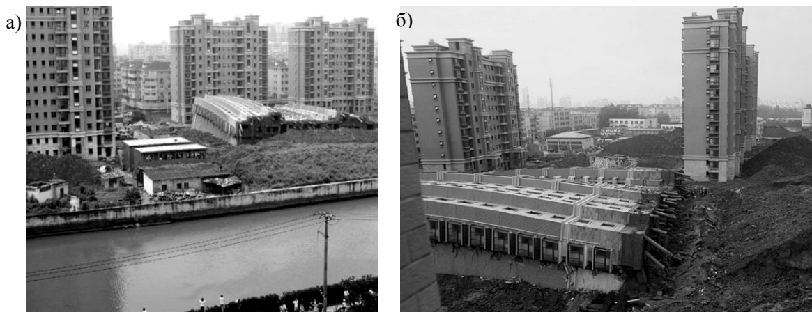
Рис. 1. Втрата стійкості 12 поверхової будівлі в Шанхаї
