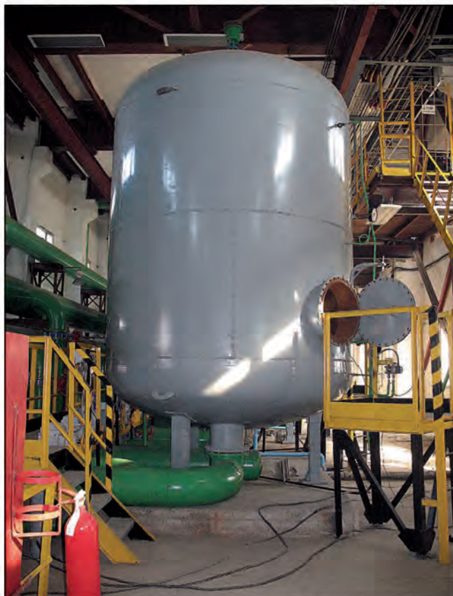
Рисунок 1 – Напорный фильтр
