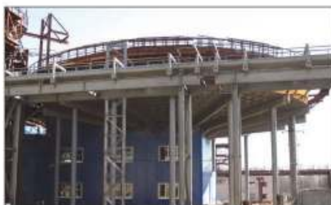
Рисунок 2 – Размещение радиальных отстойников над землей на высоте более 20 м
