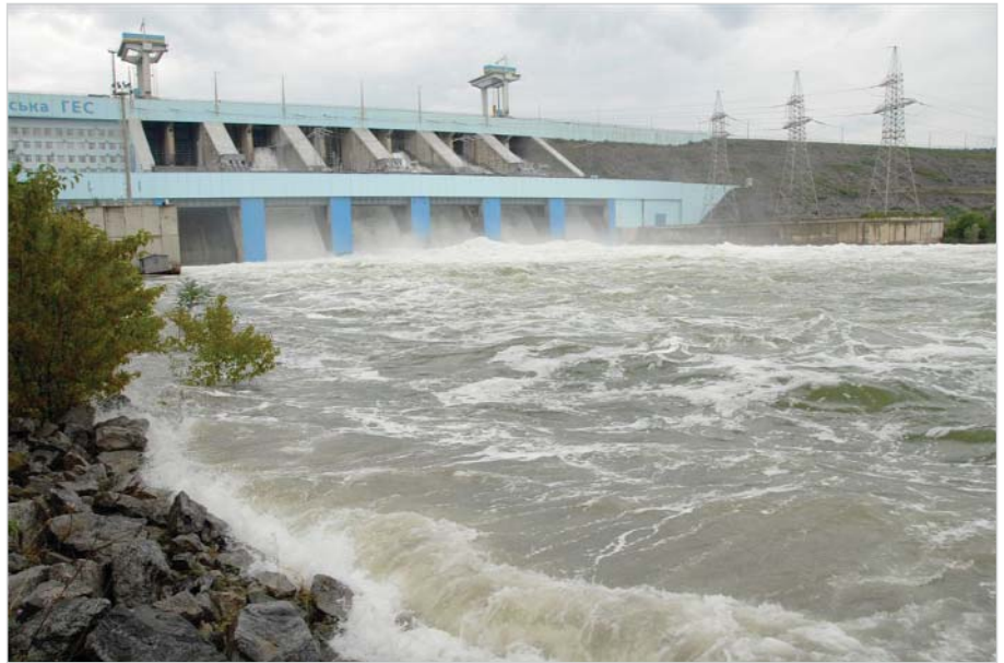
Днестровская ГЭС, пропуск паводка
