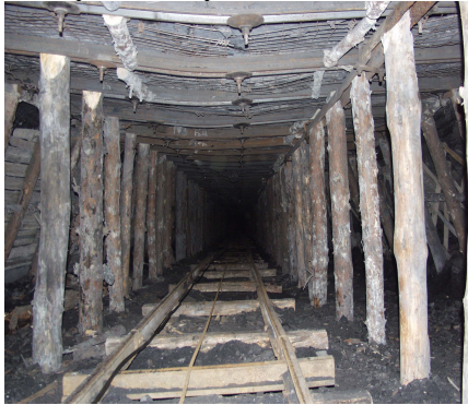
Рис. 1. Состояние монтажного ходка четвертой северной лавы уклона пласта m_4^0
