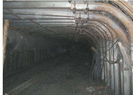
Рис. 7. Состояние выработки к моменту окончания ее проведения
