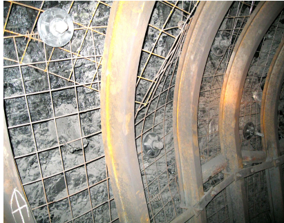
Рис. 6. Состояние пласта и непосредственной почвы в боку выработки
