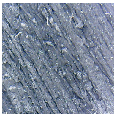
а – поверхня плити, що не була в експлуатації
