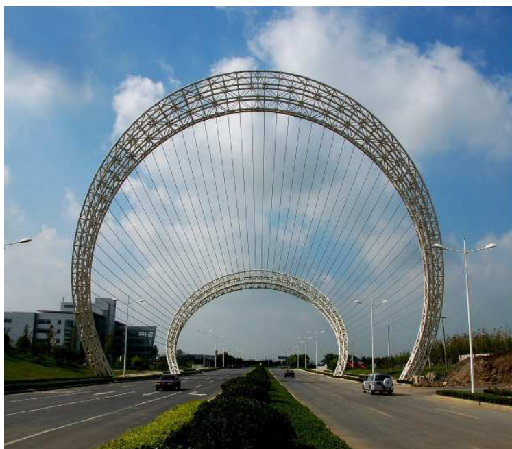
升华 高:48m 钢网结构雕塑 2004年9月 地点:苏州工业园区独墅湖高教区入口
